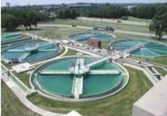
تصفیه آب در تصفیه خانه
